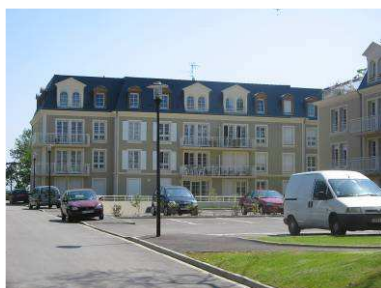
Opération av. d'Hastings
